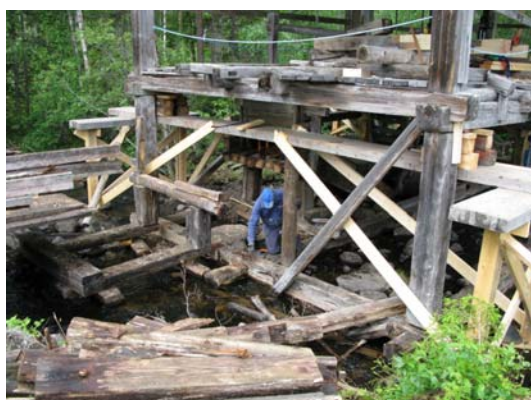
Upplyftad och klar för renovering
