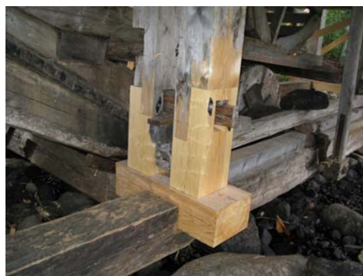
Detalj av lagad stolpe
